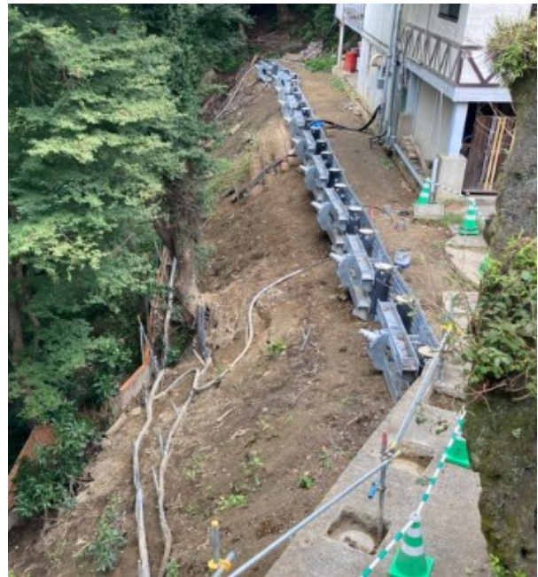
斜面对策工事
