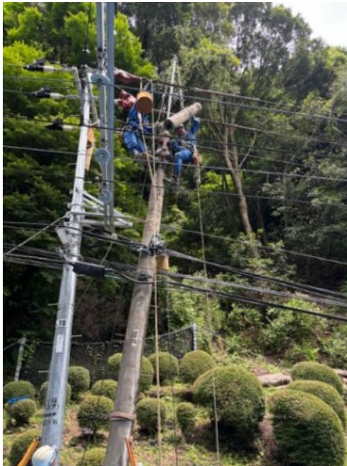
電力柱更新工事
