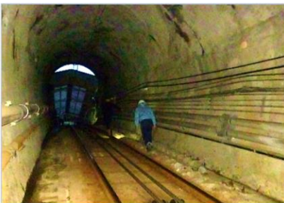
隧道出口に見える高尾山駅
