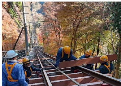
枕木交換工事
