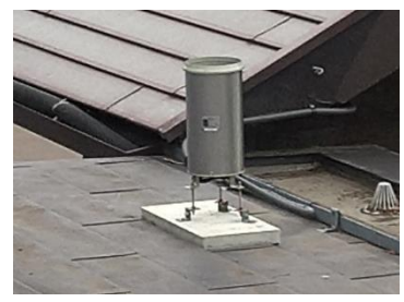
雨量計新設工事
