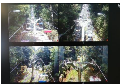
沿線監視装置更新工事
