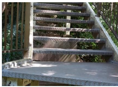
山麓駅階段補修工事
