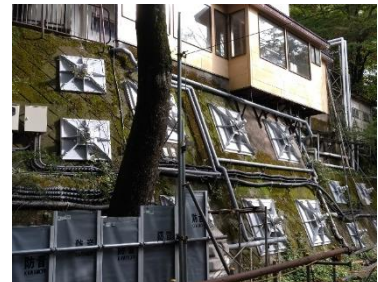
斜面对策工事
