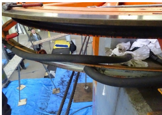
振れ止めゴム交換
