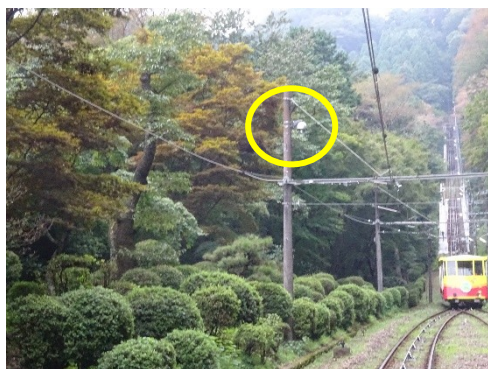
中間カメラ設置
